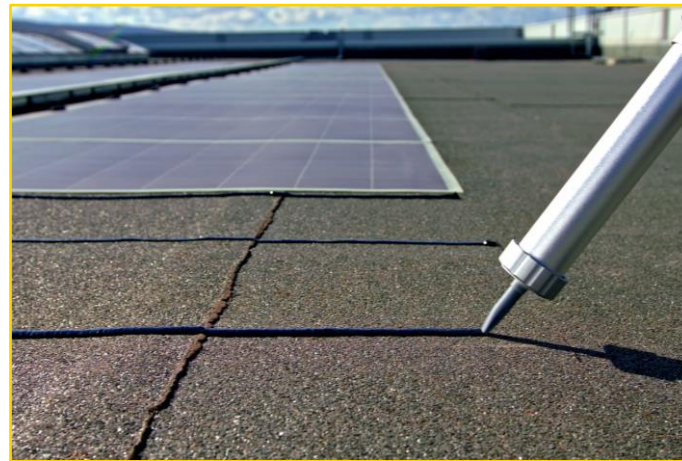
Hi-Tech-Verklebung von flexiblen Photovoltaik- und Fassadenmodulen
