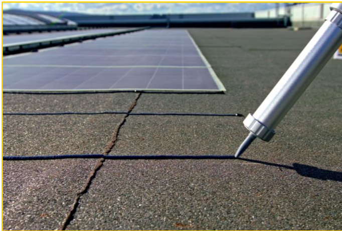
Photovoltaik- und Fassadenverklebung
