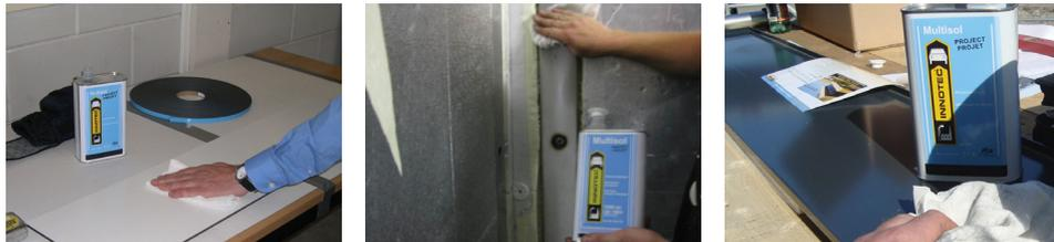
Multisol Project ist ein professioneller Reiniger für Metalluntergründe und Fassadenplatten vor Verklebungen, Abdichtungen oder anderen Arbeiten. Er entfernt auf schnelle und effiziente Weise Klebstoff- und Dichtmassen-Reste, Öle, Fette, Schmutz und Silikonreste.
